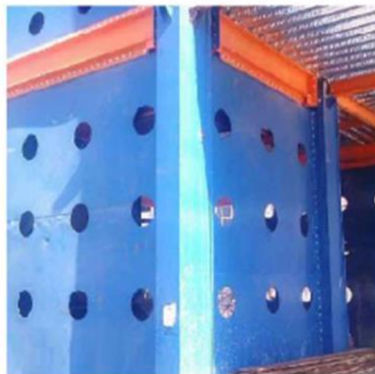
شکل ۲-۱۳، دیوار برشی حفره‌دار [۱۰]
